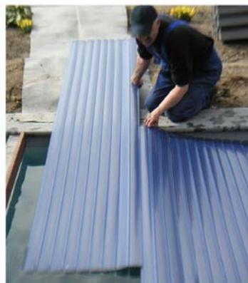
**ACHTUNG:** Lamellen mit geschweißten Endkappen können auch geschoben oder geklickt werden. Sie müssen aber die fehlende Endkappen befestigen sobald die Lamellen am Wasser liegen. Die Lamellen nicht aufwickeln falls Endkappen fehlen! Mit einem Schraubenzieher können die Endkappen demontiert werden.
